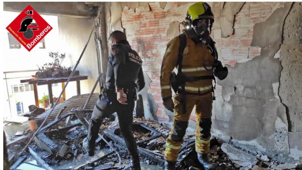
Interior de la vivienda calcinada // ABC
